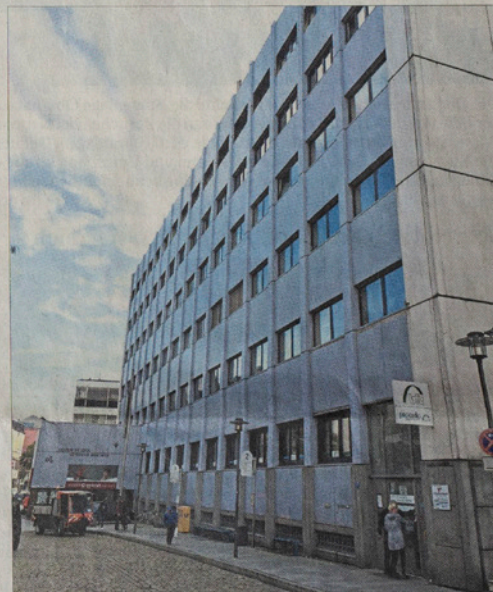
Im einstigen Postamt wurden dieser Tage umfangreiche Umbauten für neun Wohnungen im 5. Stock abgeschlossen. Nebenan könnte ein viergeschossiges Parkdeck entstehen. Im Erdgeschoss am Rande der Wissenswerkstatt (Hintergrund) soll es ab Frühjahr neue Gastronomie mit Außenbestuhlung geben.
